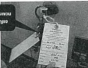
จากรูป แสดงการตัดแยกระบบไฟฟ้า ที่ Sub Station
